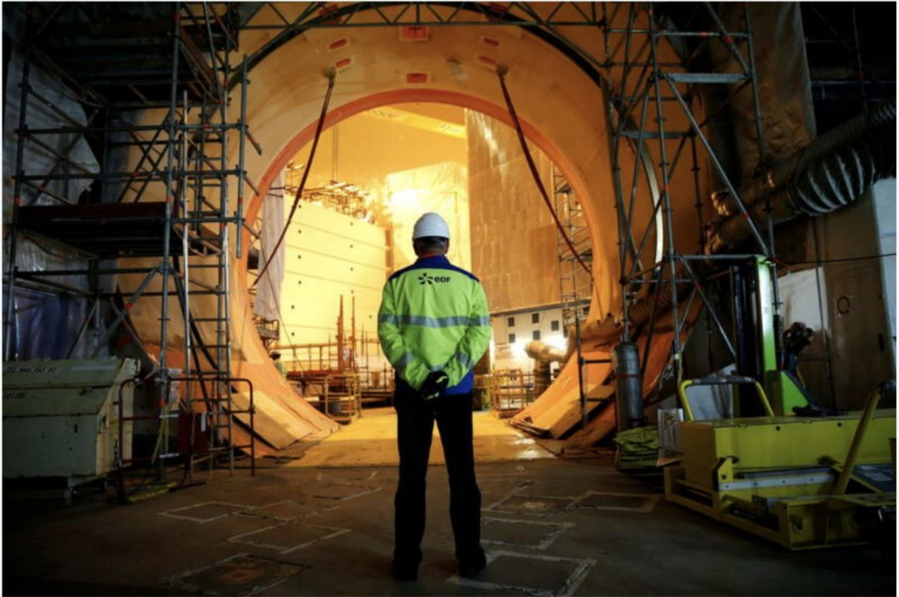
Un employé d'EDF sur le chantier de la centrale nucléaire de Flamanville, le 16 novembre 2016. (Benoit Tessier/REUTERS)
