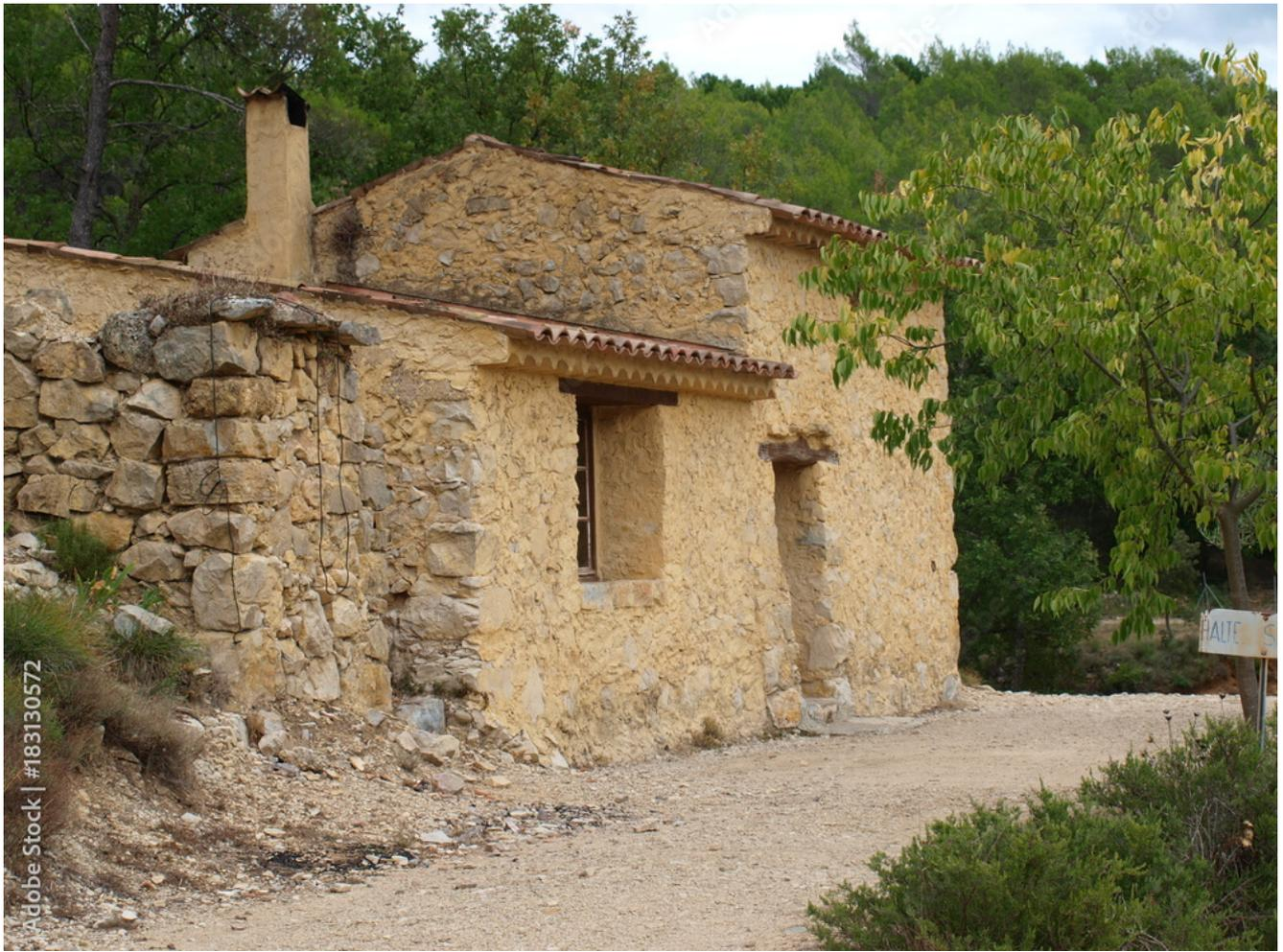
Le **cabanon**, c'est d'abord un toit de tuiles et 4 murs en « *mortier d'agasse* »= (l'«*agasse*», c'est la pie) « *mortier fait par les pies*», c'est-à-dire un mélange à partir de ciment, de l'argile et des pierres que l'on trouve sur place. On y range les outils de son champ ou de sa vigne.
