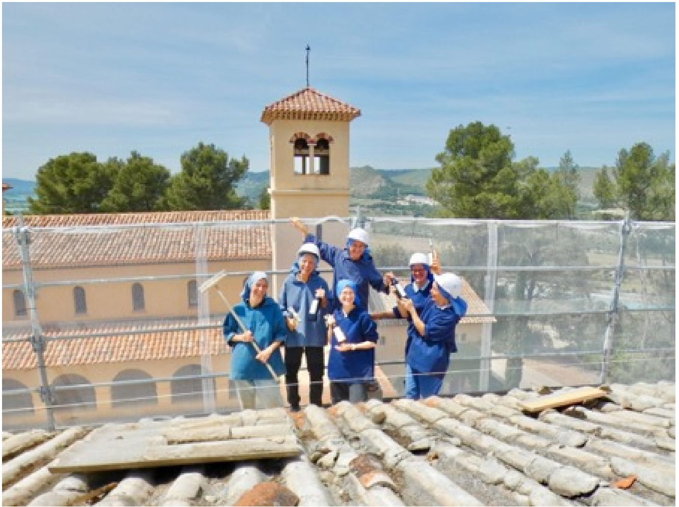
Les sœurs de l'abbaye de Jouques sur le toit du bâtiment en chantier © Abbaye de Jouques
