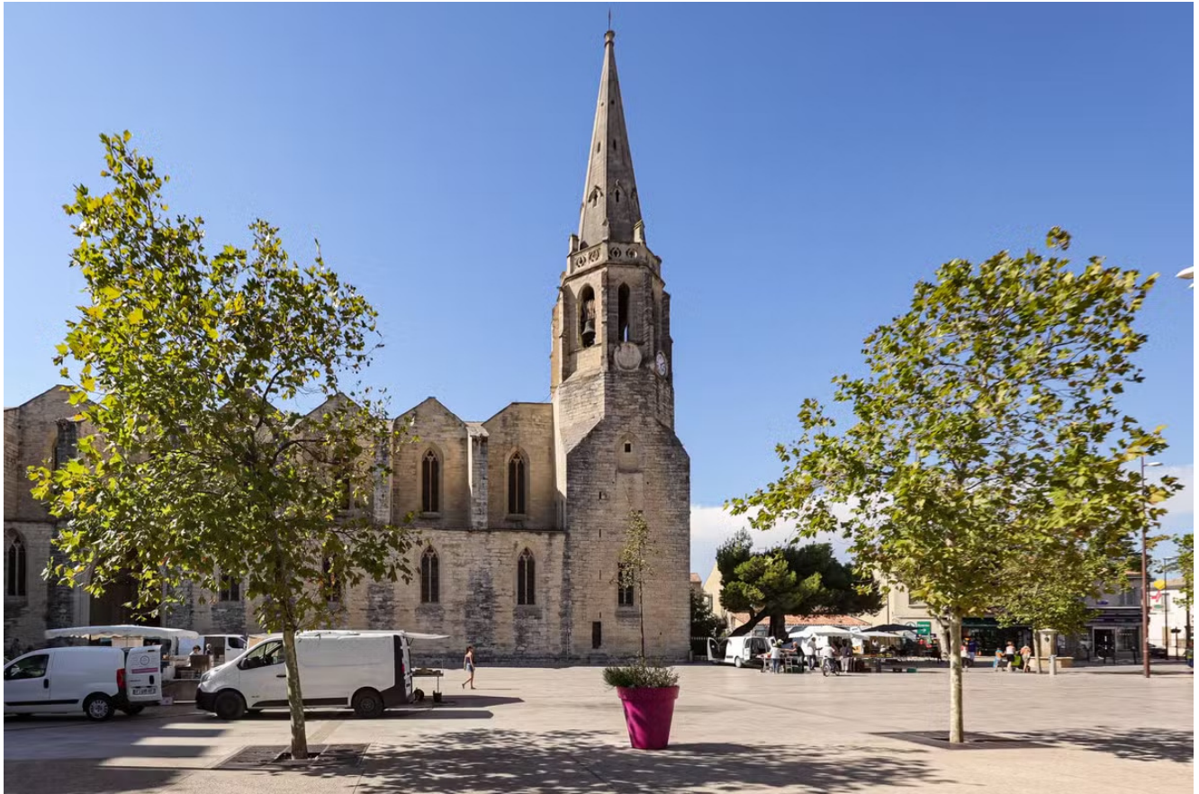
L'église de Montfavet, à Avignon, dans le Vaucluse
