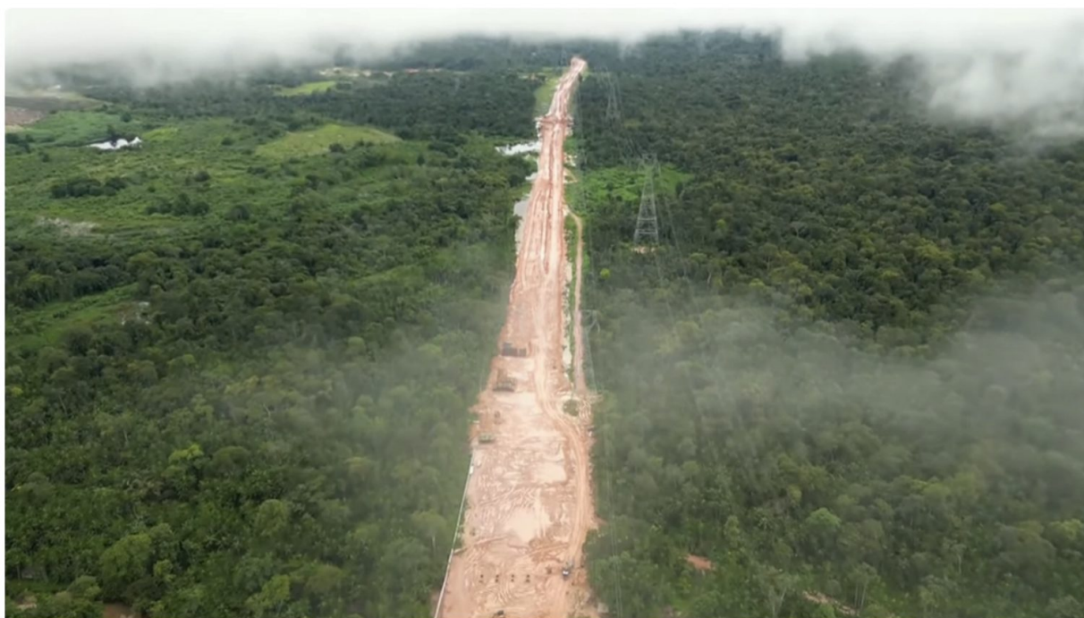
Déforestation, bétonisation, délocalisation : pour sa COP30, le Brésil réinvente l'écologie... à coups de bulldozers.
