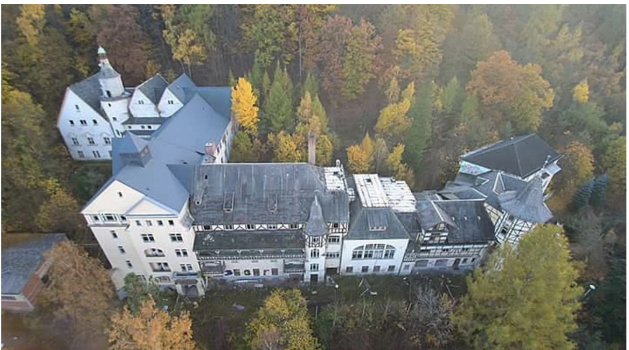
Les installations composées de sept bâtiments de l'ancien sanatorium « Schwarzeck » vues du ciel
