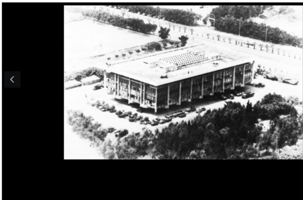
Le casernement des Marines à Beyrouth avant sa destruction.
