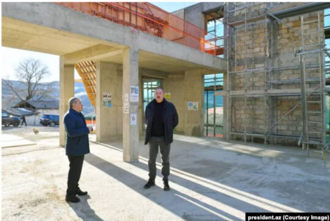
Le président azerbaïdjanais Ilham Aliyev (à droite) visitant le chantier de la mosquée de Dasalti/Karintak en décembre 2023.
