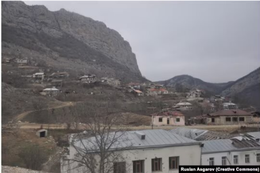
Impacts de balles sur la façade de l'école de Dasalti/Karintak (au premier plan) en décembre 2021.
