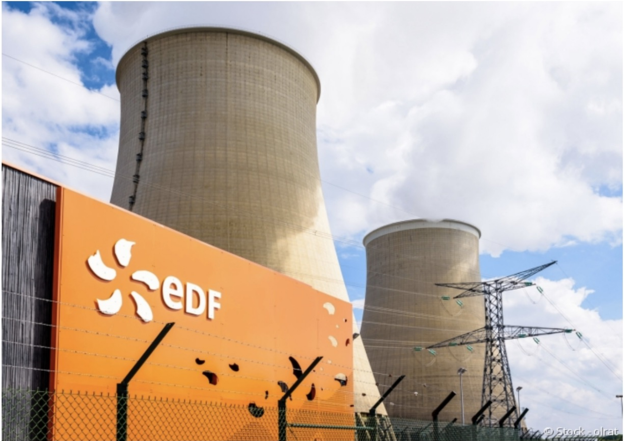
Centrale de Nogent-sur-Seine (Aube). La stabilisation des prix de l'électricité issue du nucléaire doit, entre autres, permettre d'entretenir le réseau français de réacteurs.
