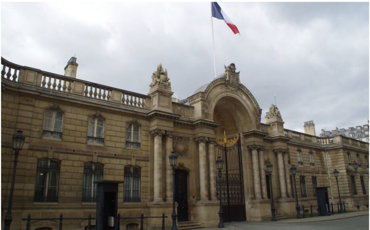
Paris (VIIIe), le 11 avril 2024. Le nettoyage de la façade de l'entrée du palais, rue du Faubourg-Saint-Honoré, ne constitue pas une « priorité », au regard des autres « interventions nécessaires sur les bâtiments d'un point de vue technique et réglementaire », selon l'Élysée. LP/Alexis Bisson
