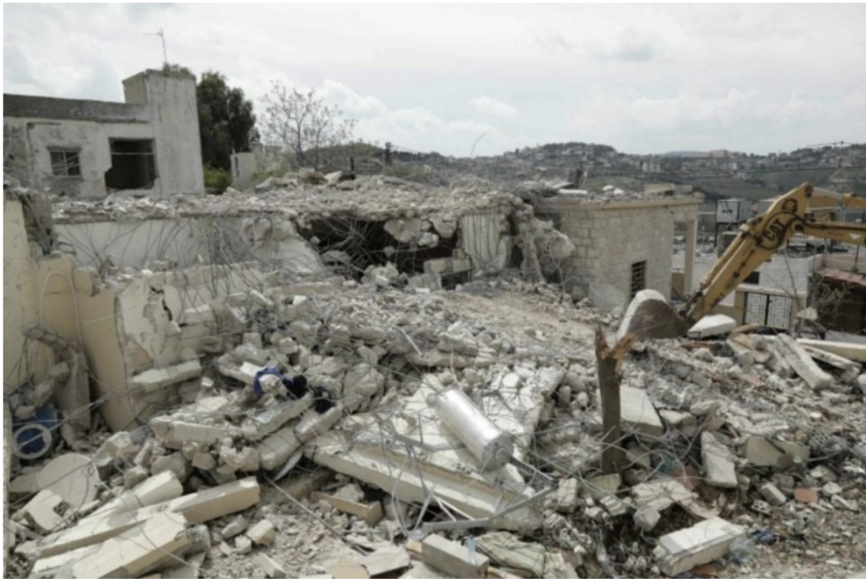
Un bâtiment détruit à Sultanieh, au sud du Liban, le 8 avril 2024 après une frappe israélienne. (Crédit : Hassan Fneich/AFP)
