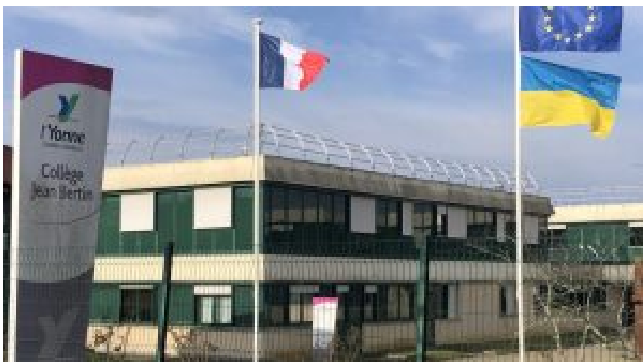
Collège Jean Bertin à Saint-Georges-sur-Baulche dans l'Yonne près d'Auxerre.
