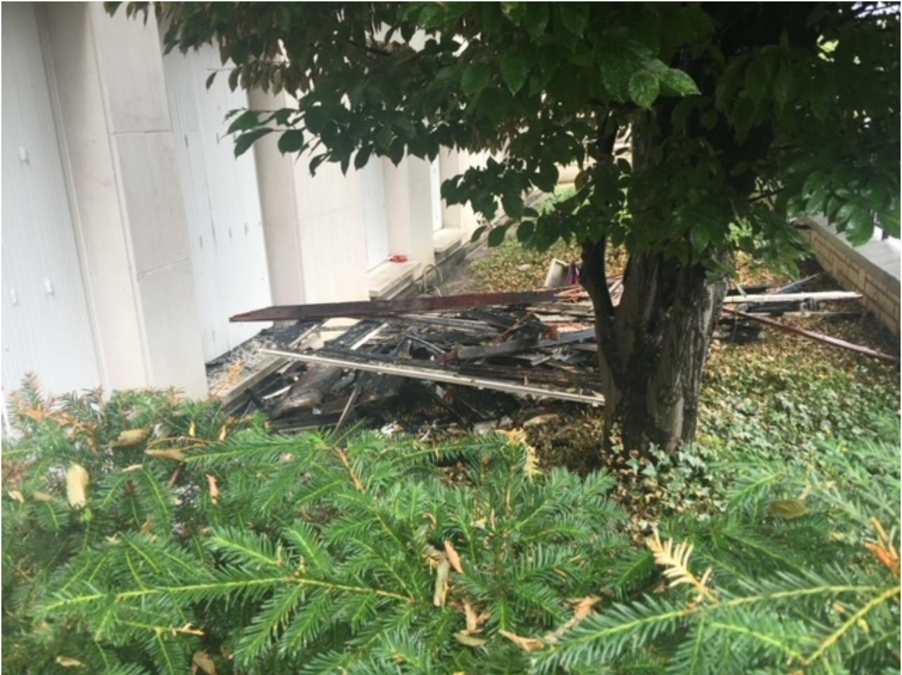
Morceaux de fenêtres ayant brûlé, en bas de l'immeuble
