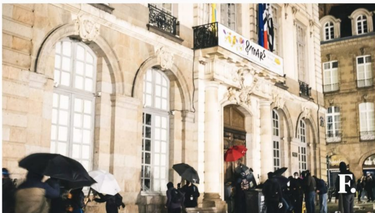
Une vaste opération de rénovation d'immeubles délabrés a été entreprise avec pour objectif d'améliorer la qualité de l'habitat tout en préservant le patrimoine historique de la ville. JUSTIN PICAUD/SIPA
