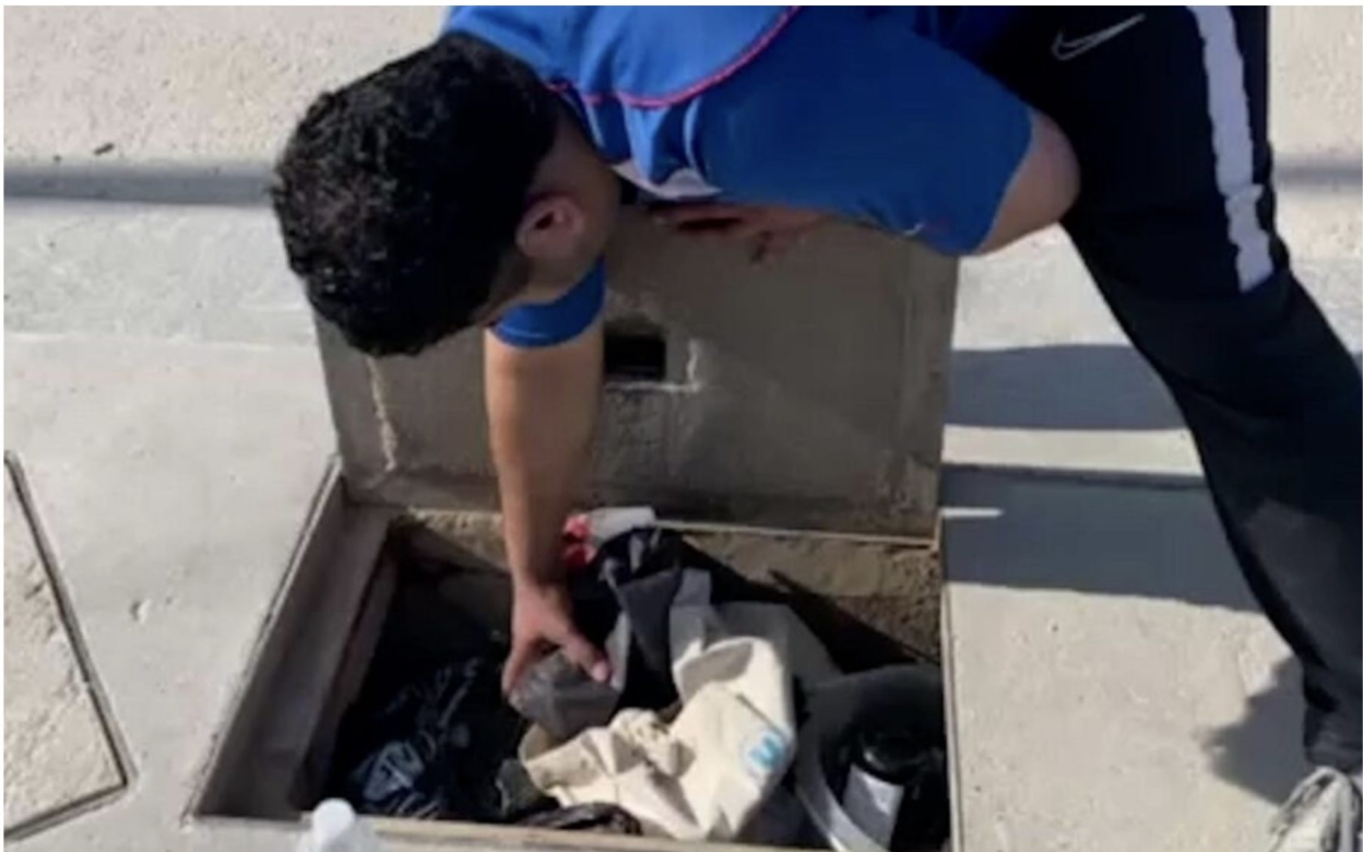
Pâte à crêpes, mais aussi brochettes, sandwichs ou bouteille de vin... Les égouts, les trappes ERDF ou de chauffage urbain font office de frigidaires de fortune. DR
