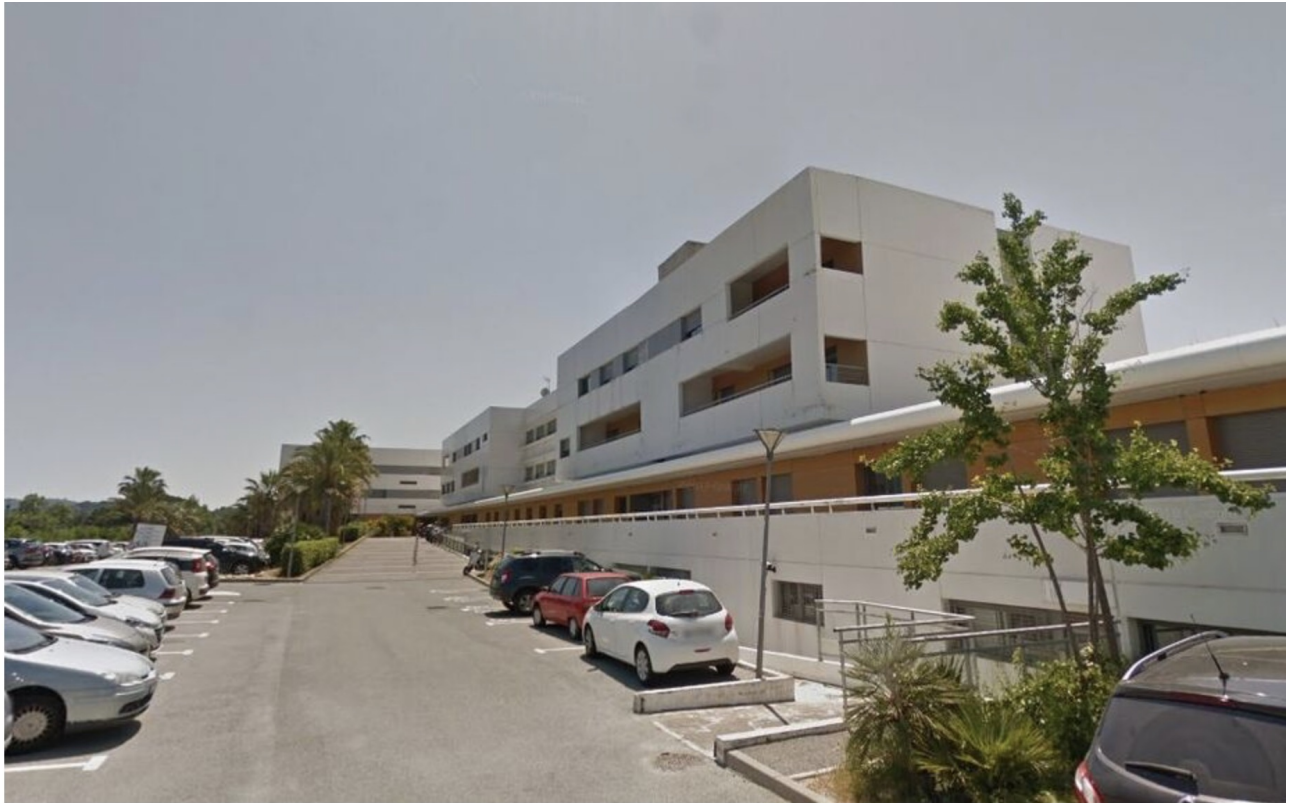
Hôpital de Saint-Tropez à Gassin (Var). Google Street View.
