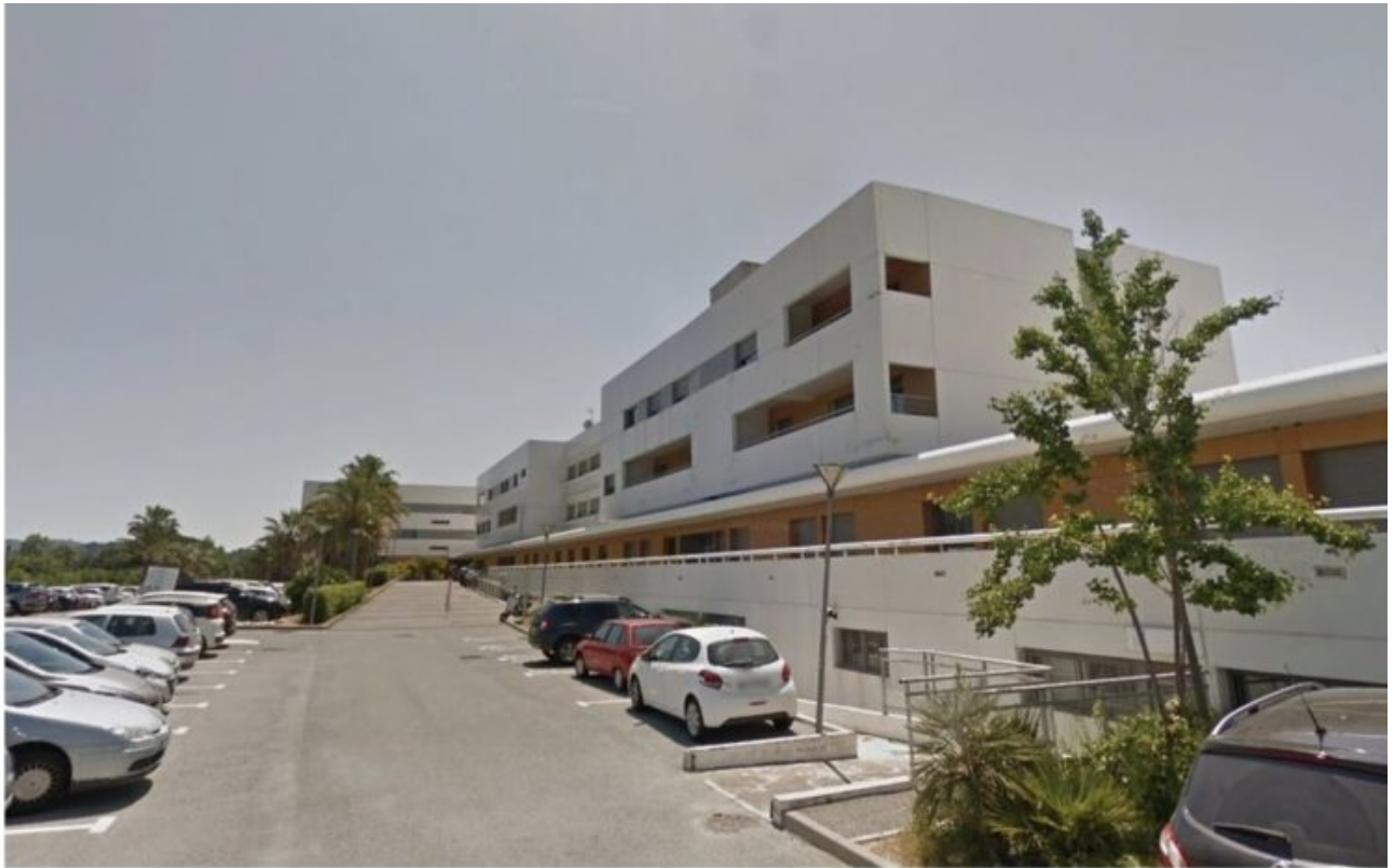
Hôpital de Saint-Tropez à Gassin (Var). Google Street View.
