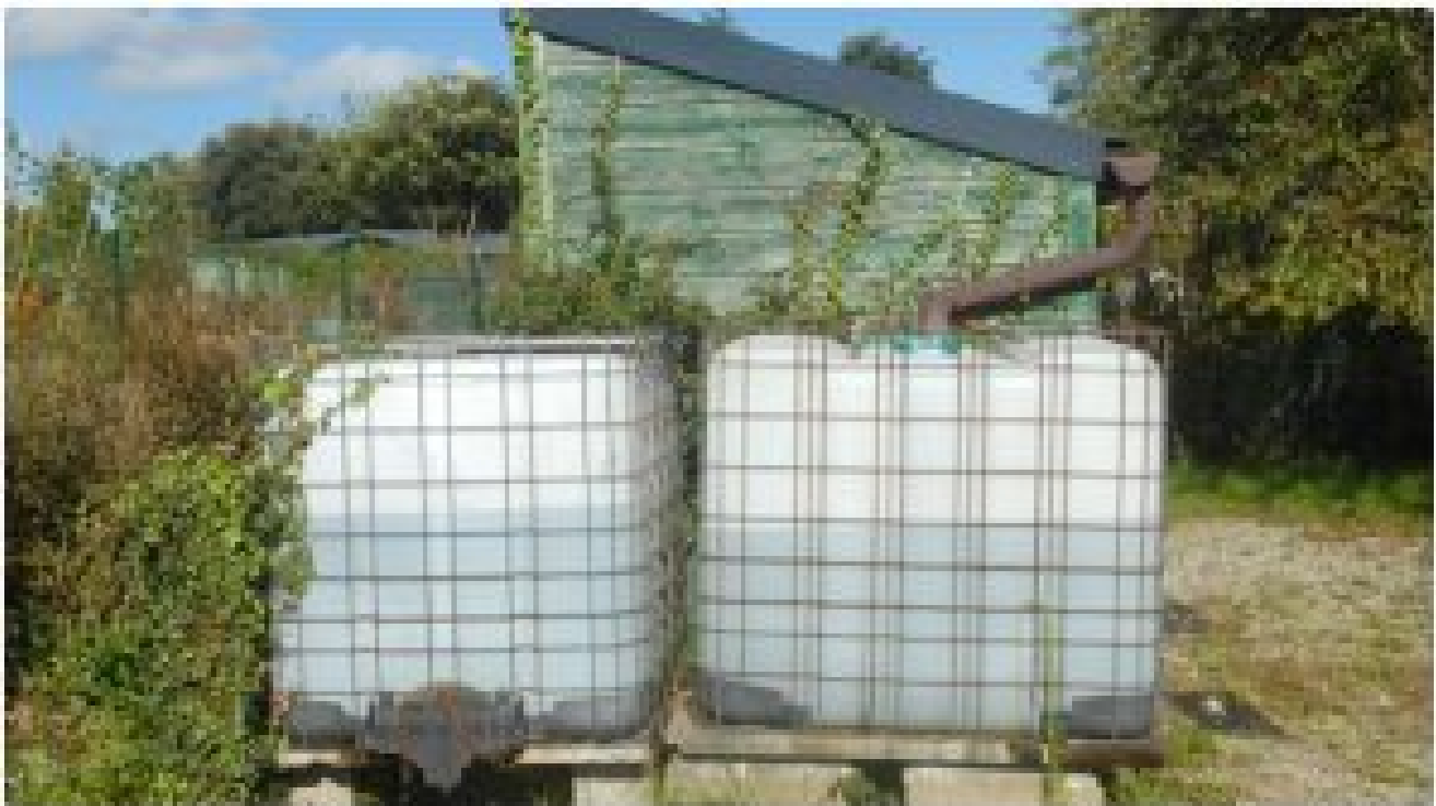
Des citernes comme celles-ci permettent à des particuliers de collecter l'eau de pluie. Il faut s'assurer que le toit ne contient ni plomb ni amiante. ■ © RICHARD VILLALON / HAUPP
