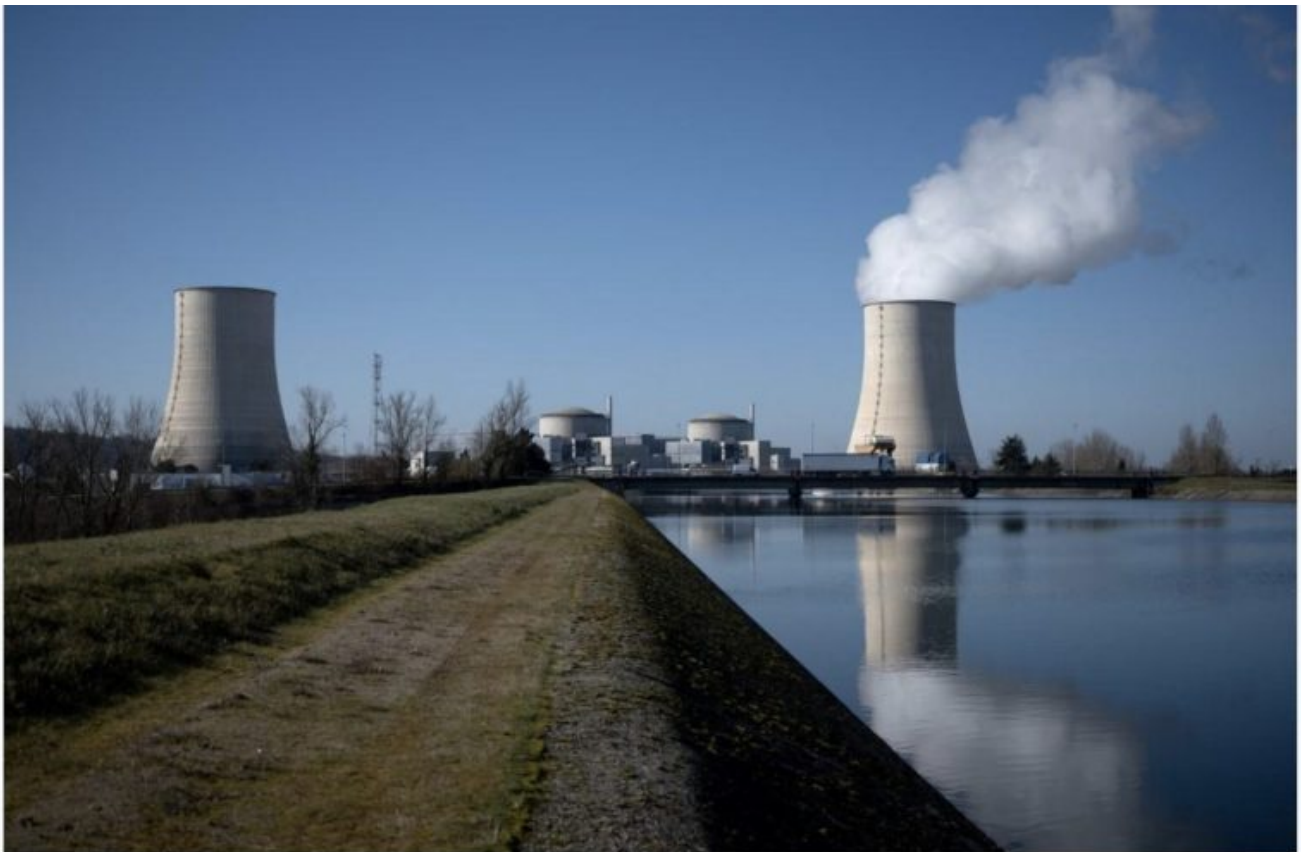
Centrale nucléaire de Golfech, le 9 février 2023.
