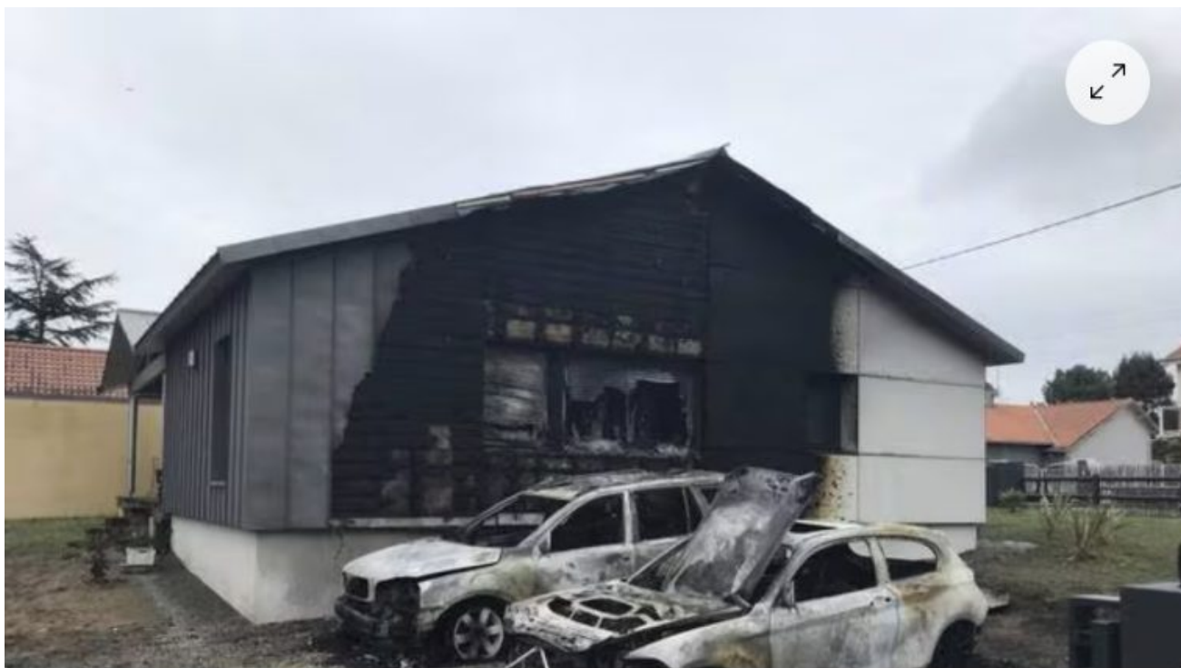
Les deux voitures et un côté de la maison ont été touchés par les flammes. | DR
