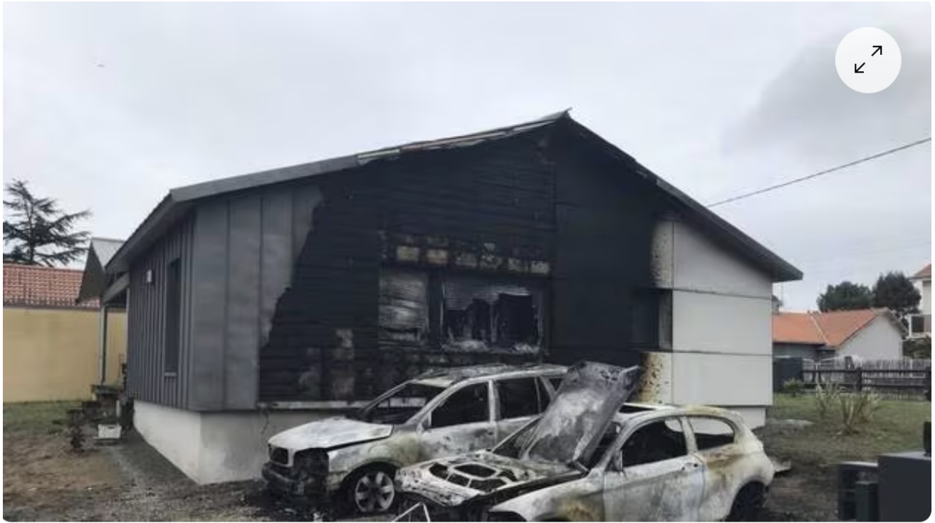
Les deux voitures et un côté de la maison ont été touchés par les flammes. | DR
