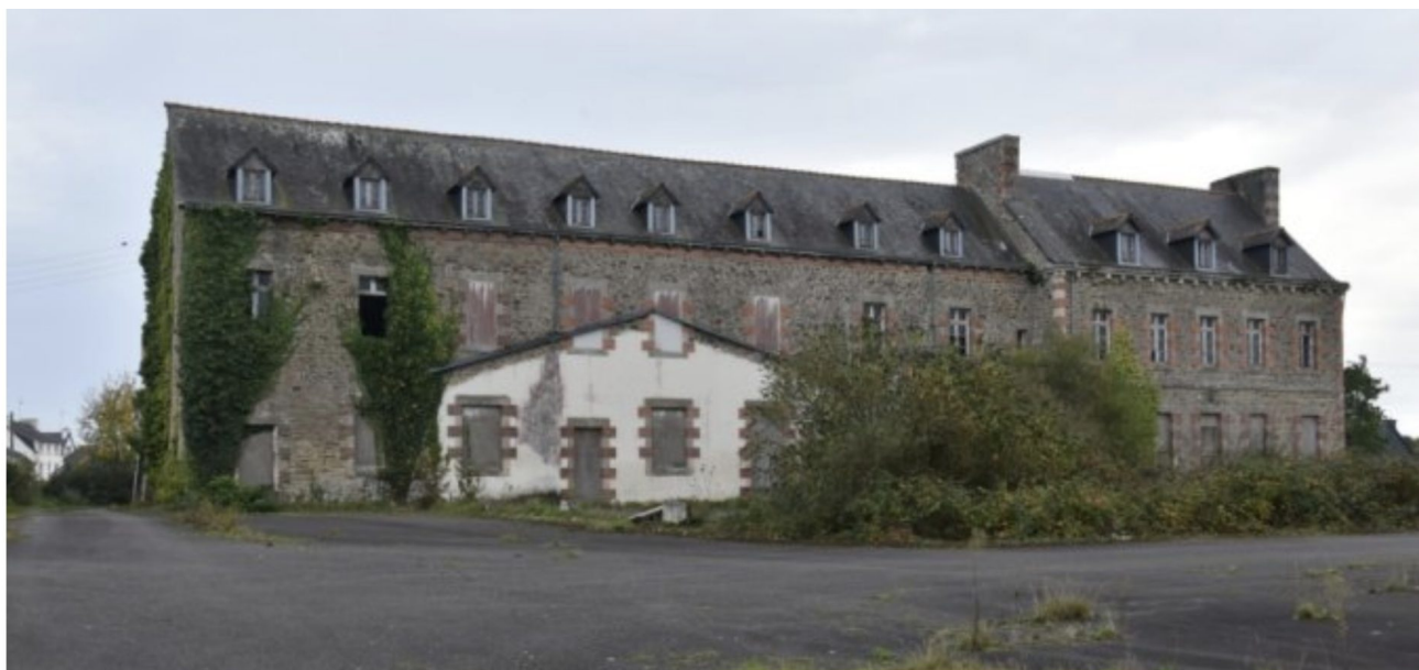
La conjugaison logements proposés (ci-dessus, l'ancien collège Saint-Laurent, une friche que la Ville veut réhabiliter) et emplois à pourvoir était une des originalités du projet Horizon d'accueil de réfugiés à Callac. (Photo Sophie Prévost/Le Télégramme)
