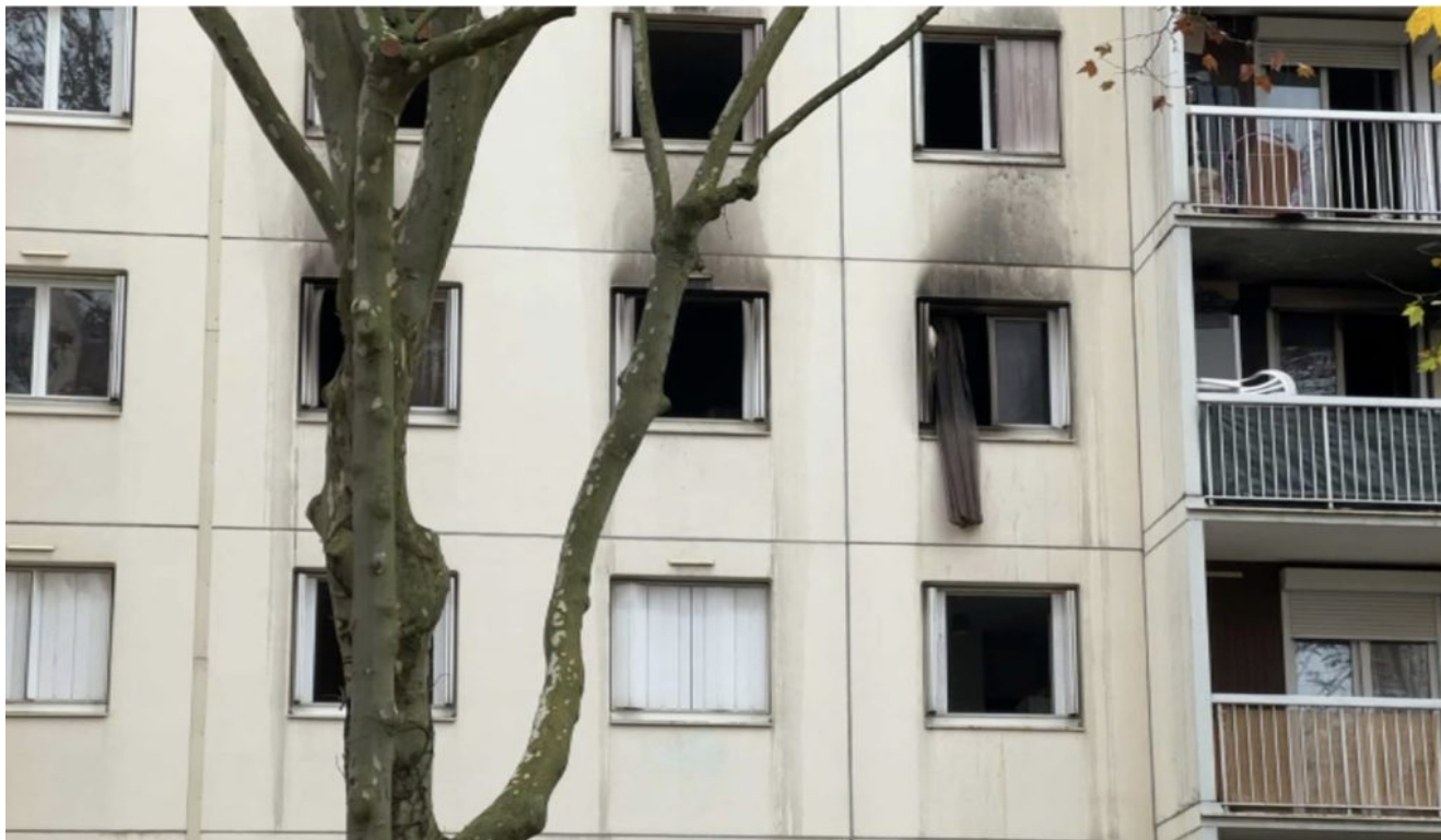
Un immeuble du quartier du Mas-Du-Taureau où un incendie a fait de nombreuses victimes, dont des enfants, à Vaulx-en-Velin, le 16 décembre 2022.
