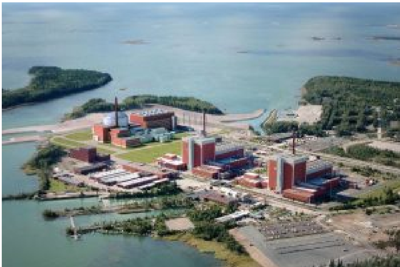
Centrale d'Olkiluoto – l'EPR est situé à gauche sur la photo.
