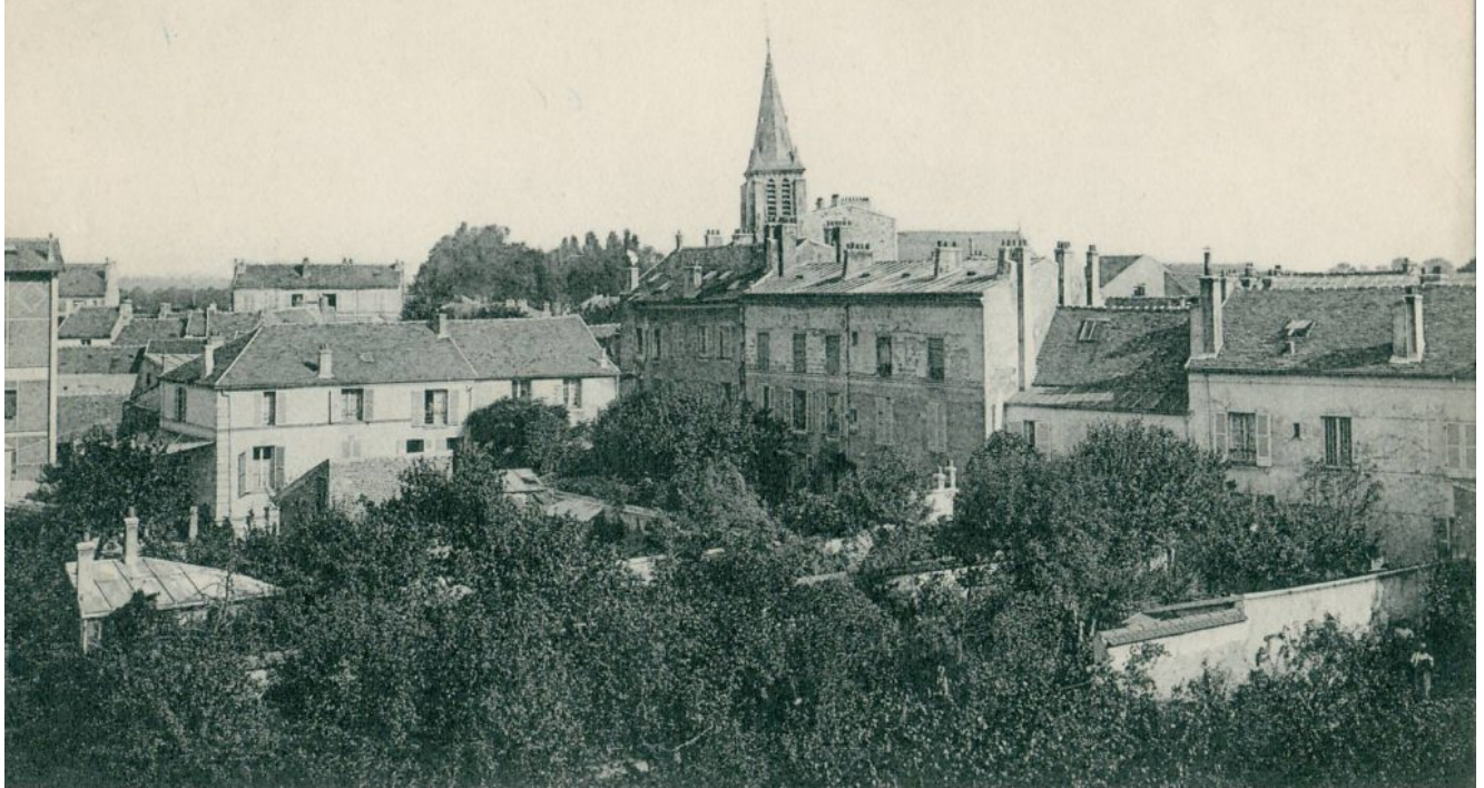
23. STAINS — Vue Panoramique (n° 1)
