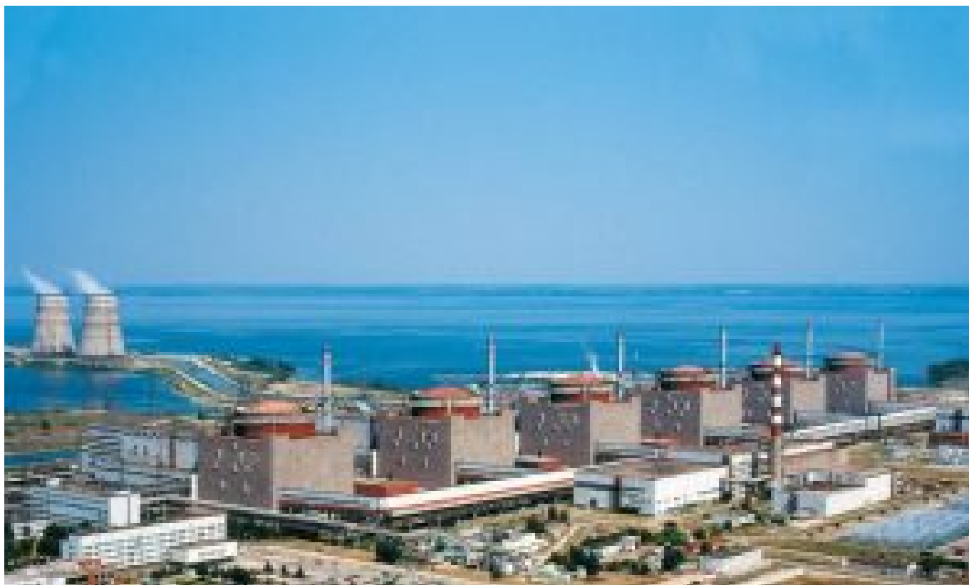
Centrale nucléaire de Zaporizhzhia, la plus importante d'Europe.
