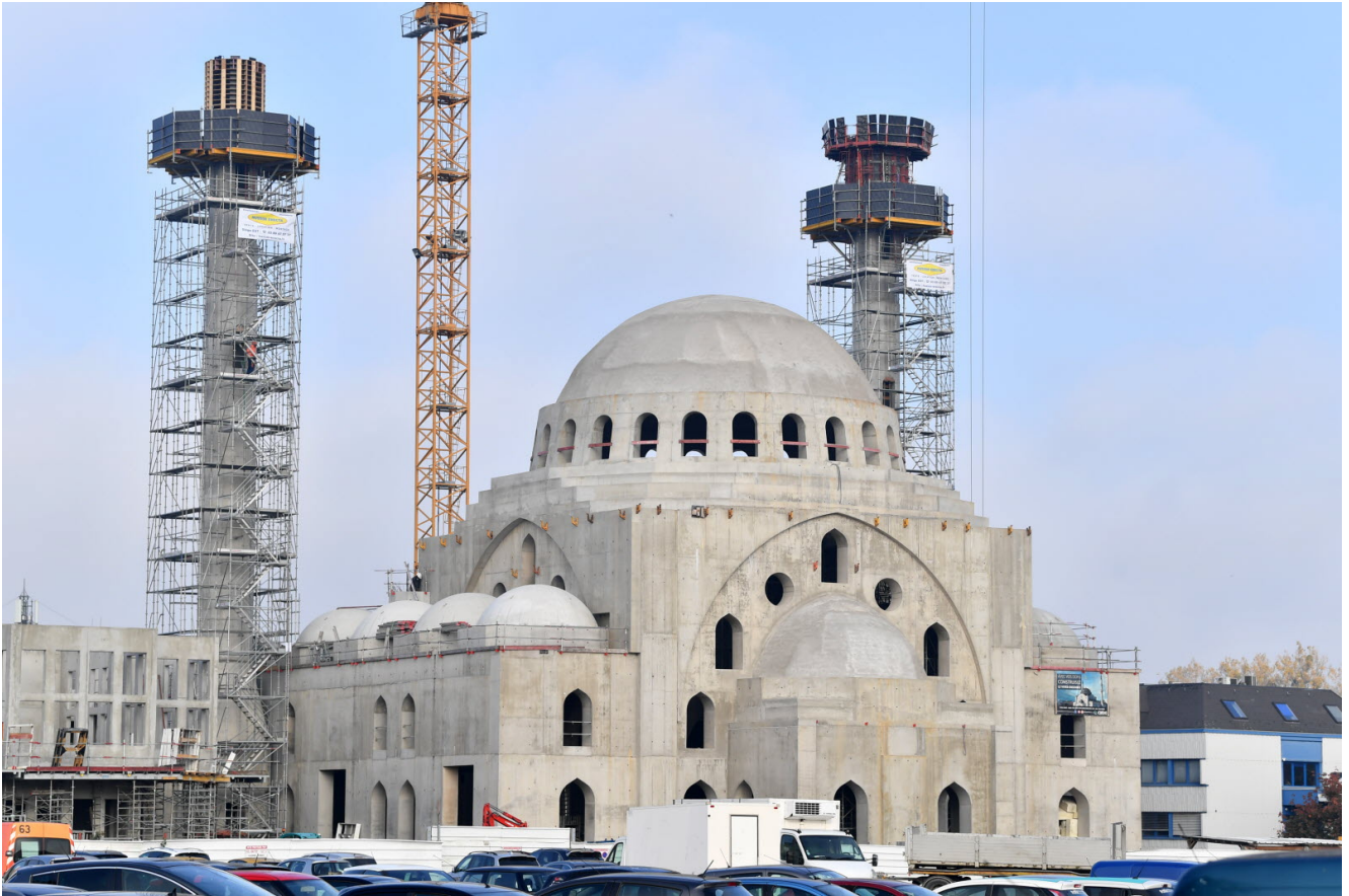
Strasbourg : le chantier de la mosquée Eyyub-Sultan avance
