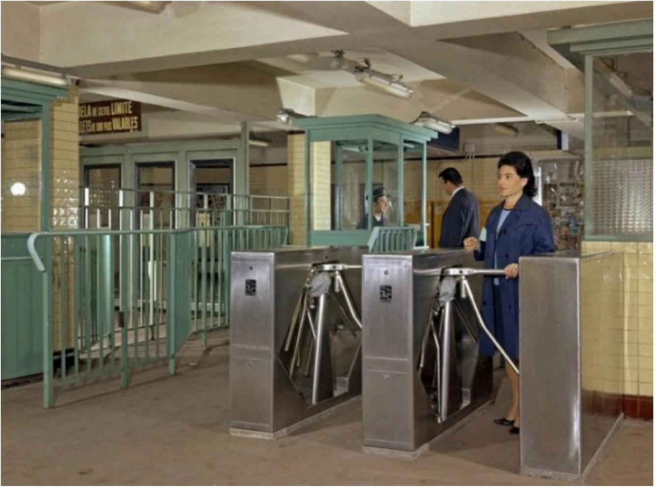
*En 1968, les premiers tickets magnétiques sont testés dans les stations Nation et Porte-de-Vanves grâce aux « appareils de contrôle automatique armés de bras tripodes » : les tourniquets. Une révolution technologique ! Dans la bande magnétique marron, qui fait son apparition, des informations – validité du ticket, date et/ou heure de passage – sont encodées. Et elles sont modifiées quand l'utilisateur glisse le ticket dans le tourniquet.*
