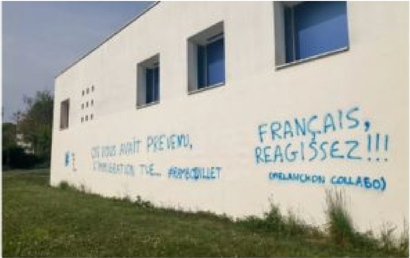
Tags islamophobes sur la façade du centre Avicenne à Rennes. © PG Crelignou FTV
