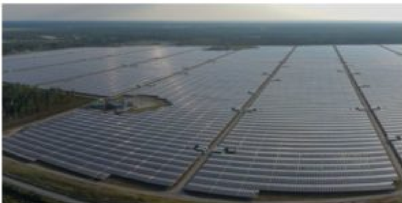
Visuellement, la densité des panneaux de la plus puissante centrale photovoltaïque d'Europe, installée à Cestas (Gironde) près de Bordeaux par Neoen, est impressionnante. (Crédits : Gambal Prod.)
