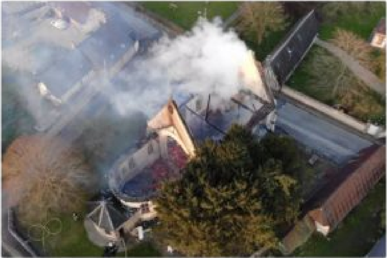
Église ravagée par l'incendie, vue par le drone des pompiers de l'Unité n° 03 (05.21)
