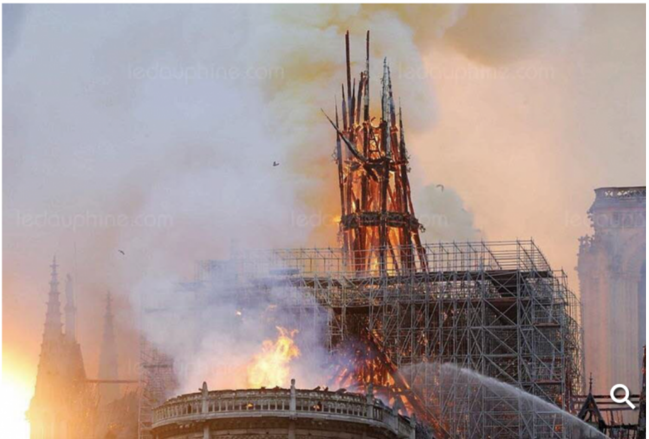
La flèche s'est effondrée sur elle-même. Photo FRANCOIS GUILLOT / AFP
