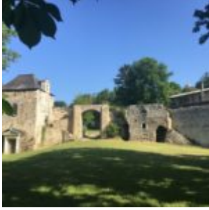
Ruines de la maison natale de Du Bellay, à Liré.
