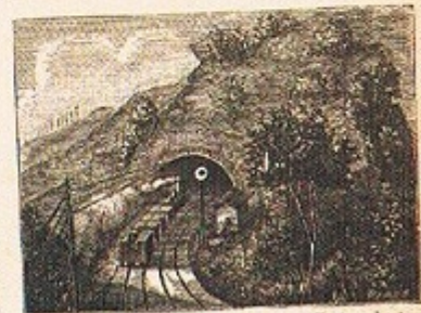
TUNNEL DE LA NERTRE, près de MARSEILLE. — Un tunnel est un passage pratiqué sous terre ou à travers une montagne, dans lequel s'engagent les trains de chemins de fer. Le plus grand tunnel de France a été le gigantesque celui de la Nertre, qui a près de 3 kilomètres de longueur. Un autre tunnel, plus grand encore, a été construit pour mettre en communication la France et l'Italie; c'est celui du mont Cenis, dont la longueur dépasse 12 kilomètres.
