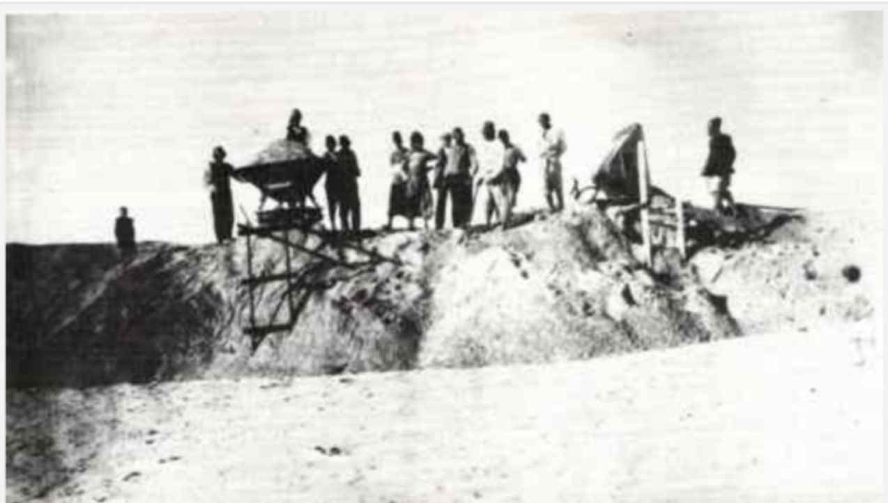
1910 Harassants travaux de terrassement dans les dunes de sable. - TEL AVIV
