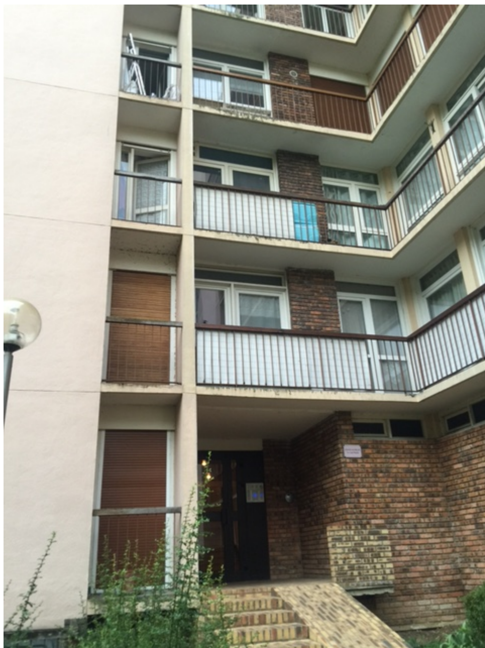
Le hall (28 septembre 2019)
