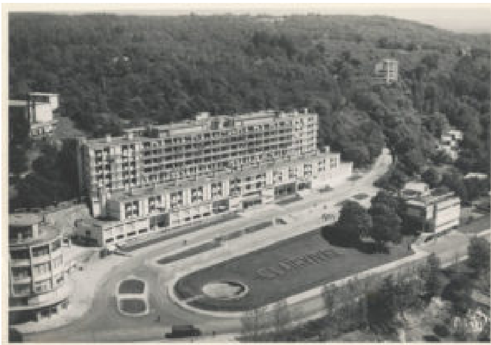
1932-1933. Hôtel, Cité sanitaire Clairvivre, Salagnac (Dordogne) : vue aérienne de l'hôtel (cliché Combier Photo Mâcon)
