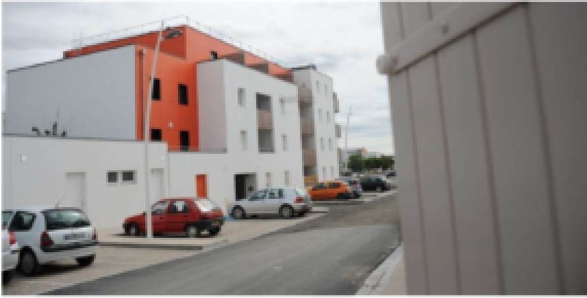
4. Exemple de réhabilitation : à Saint-Eloi, à La Rochelle, la barre de quatre immeubles qui composait la cité des Géraniums a laissé place à deux bâtiments modernes. ©PHOTO AMWER LÉOTY
