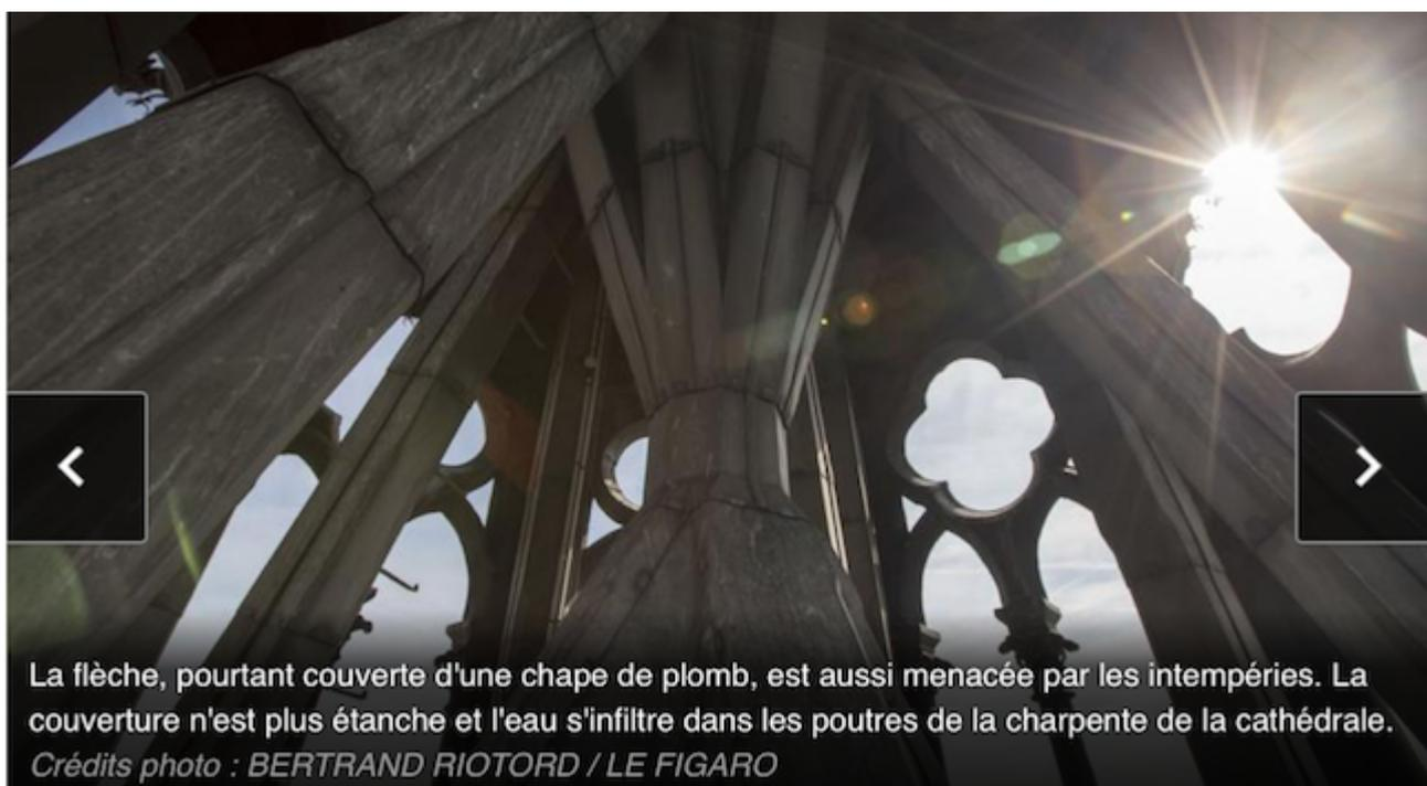
La flèche, pourtant couverte d'une chape de plomb, est aussi menacée par les intempéries. La couverture n'est plus étanche et l'eau s'infiltré dans les poutres de la charpente de la cathédrale. *Crédits photo : BERTRAND RIOTORD / LE FIGARO*
